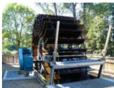
Roue Zuppinger ; Notez la présence du bloc palier-multiplicateur-génératrice.
