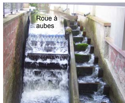
Passage à poissons à ralentisseurs
