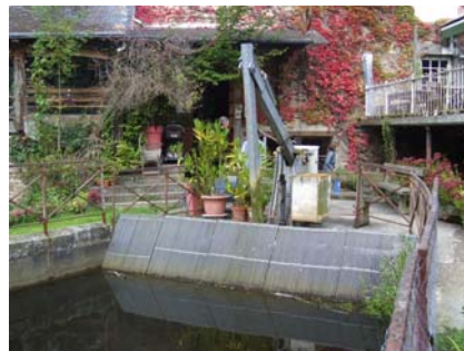
Dégrilleur hydraulique
